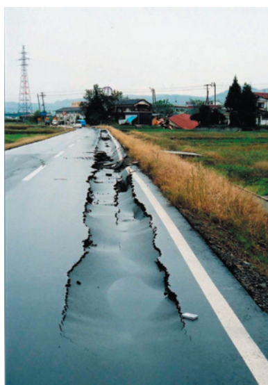
(4) 填砂・陥没
