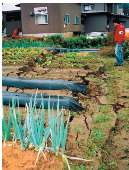
図1 地盤変状要素 (1) 亀裂
