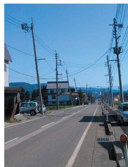
(6) 電柱の傾動
