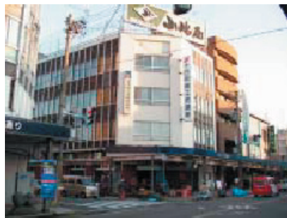
写真 29 建物Bの外観（小千谷市、手前の道路が117号）「小林克巳教授（福井大学）撮影」
