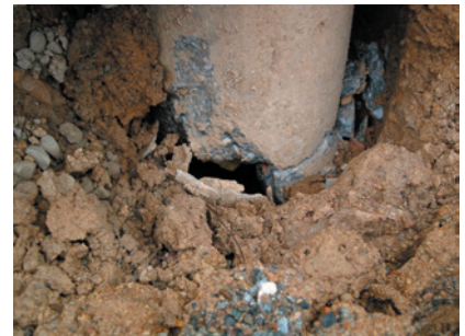
写真15 写真14の右の杭の詳細。PC杭でφ350。中空部とコンクリートが充填してある杭頭補強部の境でせん断破壊。
