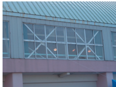
写真 38 川口中学校 元々の X ブ レースの他に V ブレースの補強 がされている
