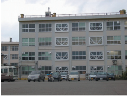
写真7 十日町高校第2棟（RC4F, 補強済み）の北面の外観。被害は軽微
