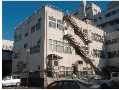
写真 23 小千谷総合病院の北西側張り出し部分：1Fの柱がせん断破壊し、軸耐力を失っている。柱の詳細は次の写真。
