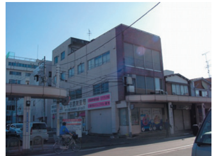
写真 27 建物Aの外観（小千谷市、手前の道路が117号）
