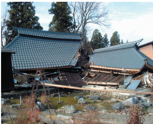
写真.4 伝統構法住宅の倒壊状況
