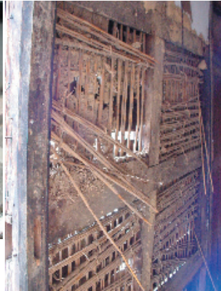
写真.25 土塗壁の崩落 (No.1)
