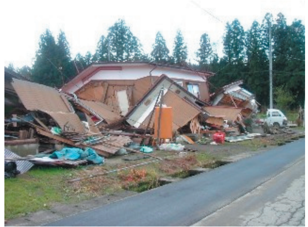
写真.3 在来軸組住宅の倒壊状況
