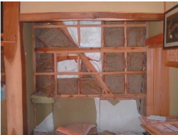
写真.8 片筋かいをもつ石膏ボードの壁
