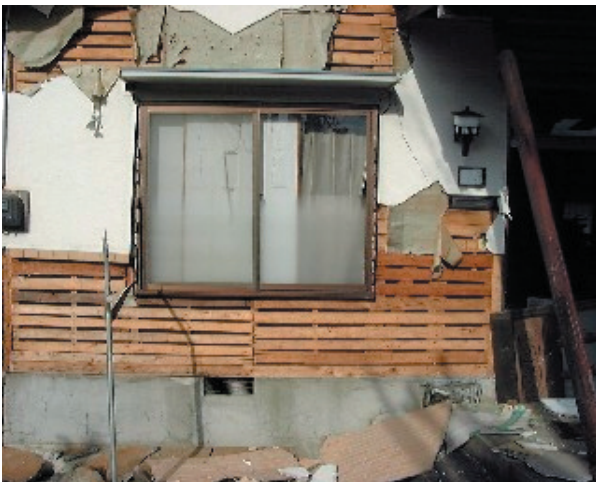
写真.10 外壁の剥落
