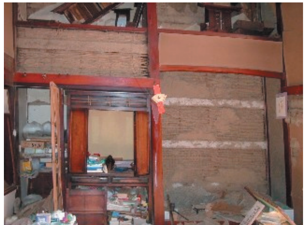
写真.9 筋かいのない土壁
