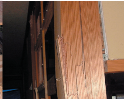
写真.16 柱の折損
