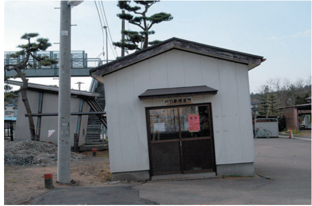
写真 -15 液状化による刈羽駅待合所の傾斜
