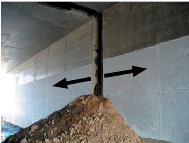
写真-5 関越道横断ボックスカルバートの移動
