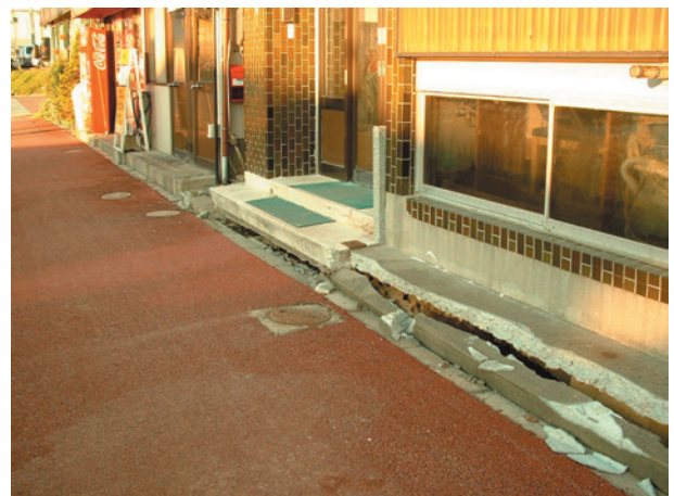
第8図.地面が沈降し抜け上がったビル(本町2丁目)
