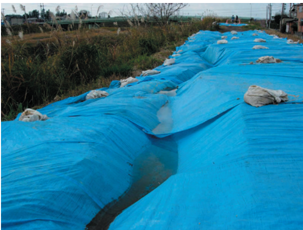
第 10 図. 大きく沈降した刈谷田川の堤防（南本町 1 丁目）
