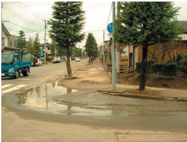
第4図.舗装の境界からの噴砂(南本町2丁目)
