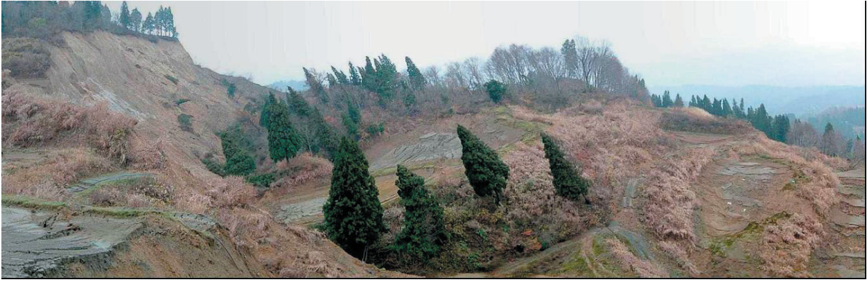
写真 19. 小千谷市塩谷の地すべり頭部
