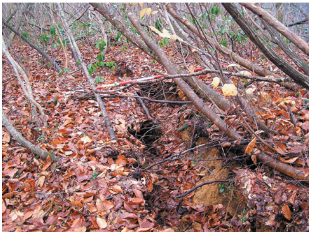
写真7. 地すべり頭部に见られる開口亀裂（東竹沢）
