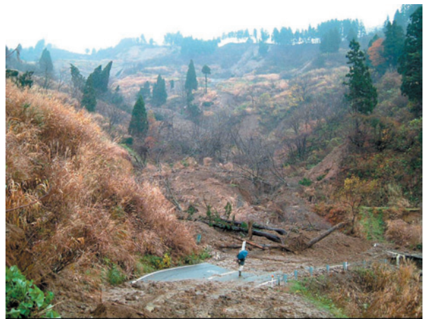
写真 17. 朝日川左支三石川上流の地すべり
