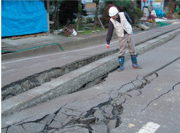
図3 消雪パイプの破損（小千谷市）
