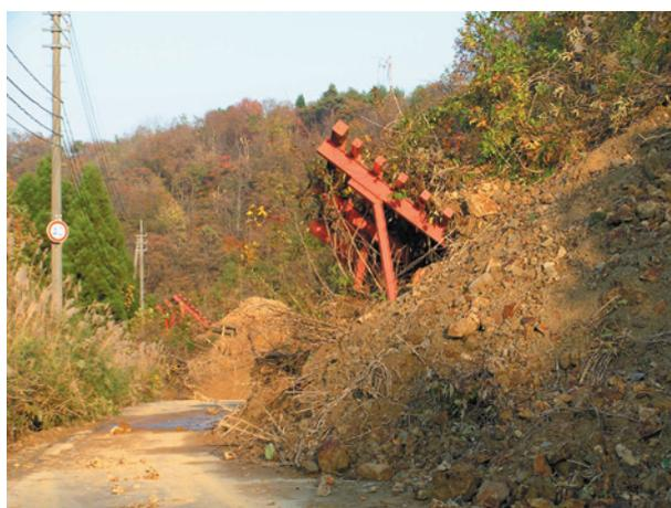
図1 基礎ごと崩落した雪崩予防柵（小千谷市）
