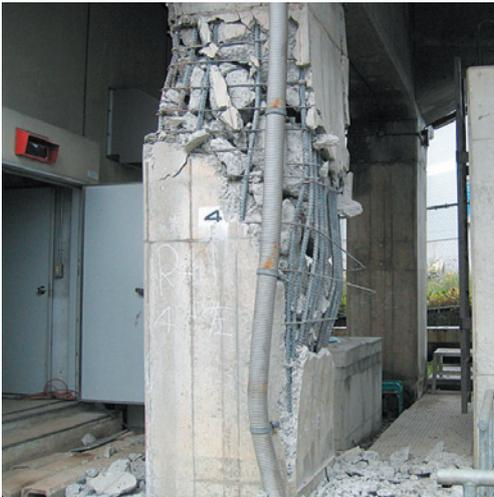
新幹線の高架橋柱のせん断破壊 (91頁)
