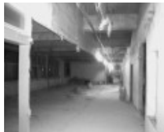
改修工事中の理学部校舎
