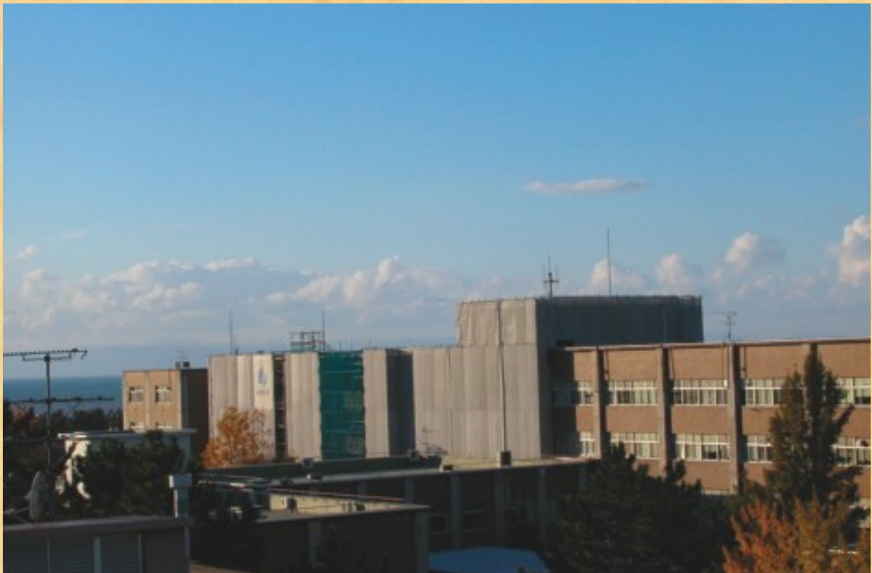
改修工事中の理学部校舎（3年計画の第1期分）
