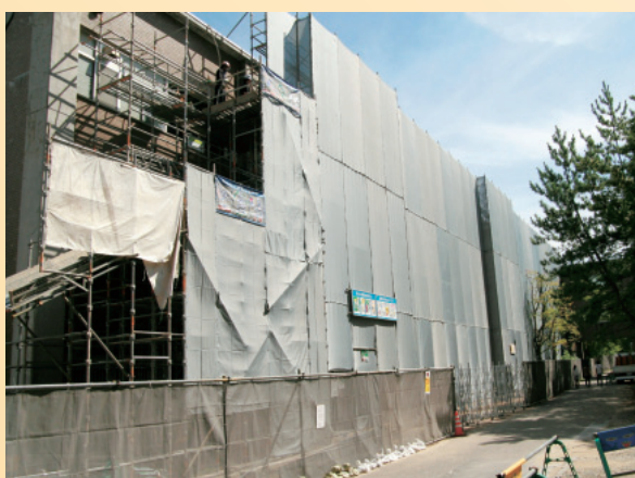
C棟西側改修工事始まる。平成21年3月完成予定
