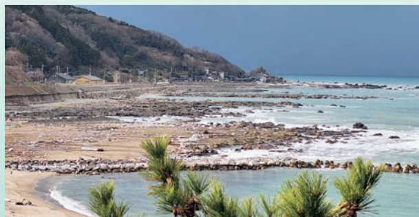
能登半島では地震による海岸部の隆起が各地で確認された
