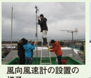
風向風速計の設置の様子
